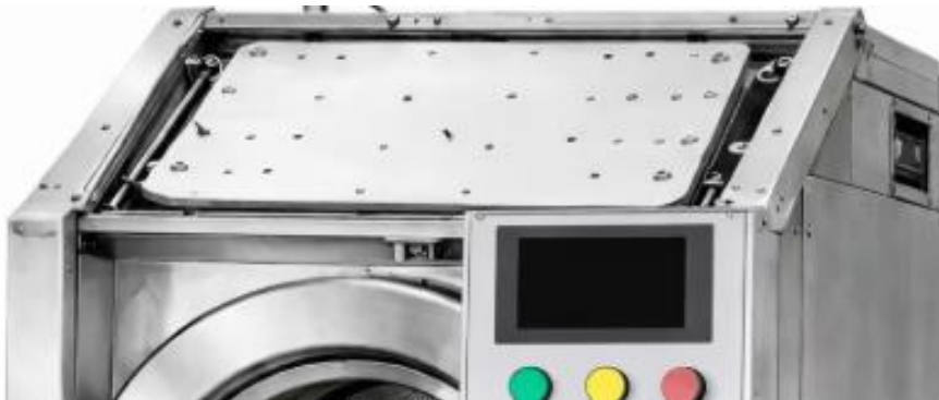
< 혼합기 상단 동흡진기 설치모습 >
